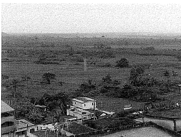
Fig 33: Ocupações irregulares na microbacia do córrego Ribeirão
